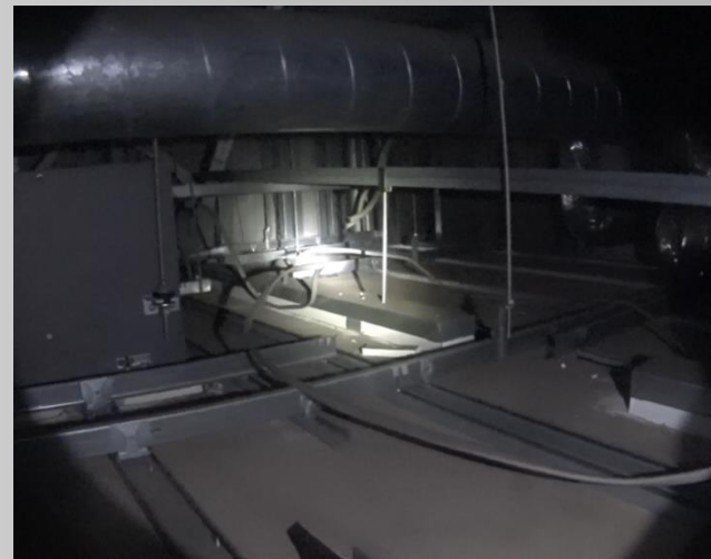
Fig. 点検口から見た天井裏
