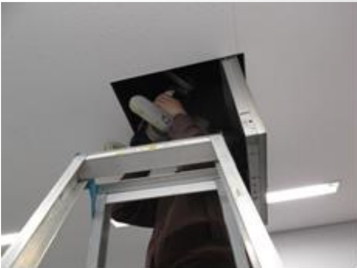
Fig. 天井裏への投入
